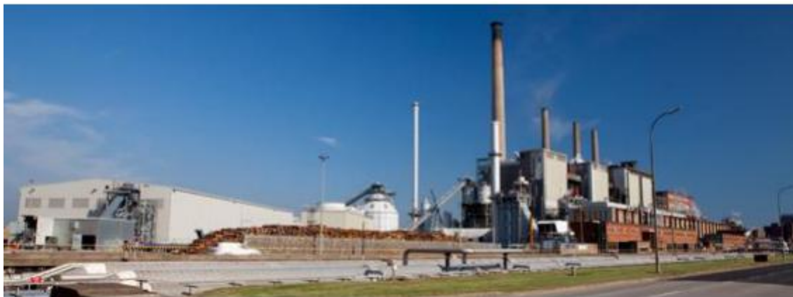
Εργοστάσιο Συμπαράγωγής Ηλεκτρισμού - Θερμότητας : Wilton 10
