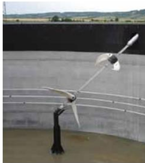
Αναδευτήρες κρεμασμένων πτερυγίων (αριστερά) και η αντίστοιχη μηχανή ανάδευσης (δεξιά)
