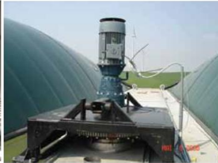
Αναδευτήρες κρεμασμένων πτερυγίων (αριστερά) και η αντίστοιχη μηχανή ανάδευσης (δεξιά)
