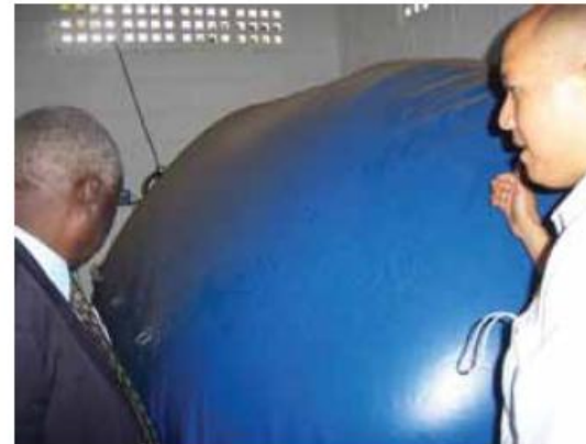
Εξωτερικές δεξαμενές αποθήκευσης αερίου χαμηλής πίεσης
