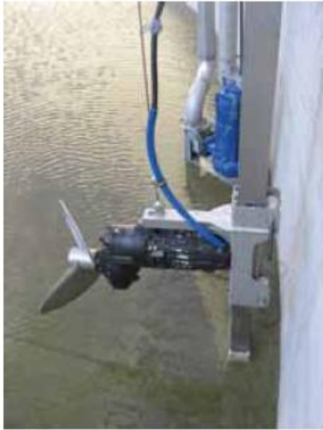
Αναδευτήρας έλικας με καταδυόμενο μοτέρ
