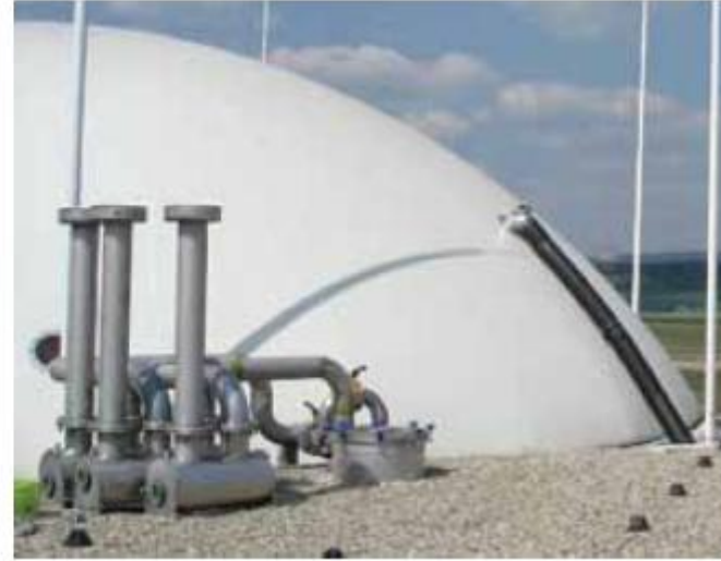
Εγκαταστάσεις πίεσης και βαλβίδες ασφαλείας
