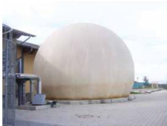
Εξωτερικές δεξαμενές αποθήκευσης αερίου χαμηλής πίεσης
