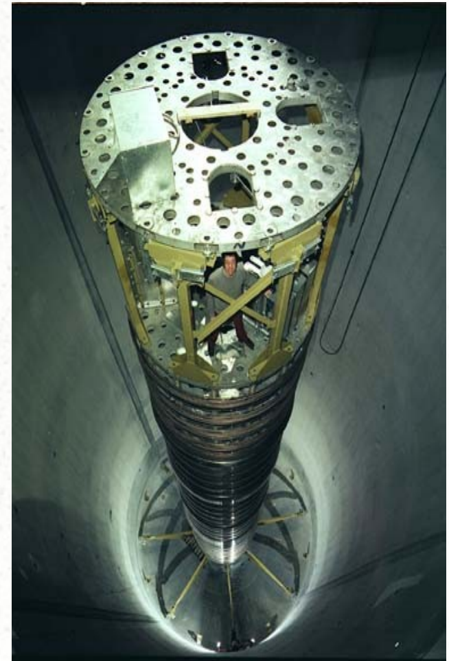
Εικόνα 10: Εγκατάσταση επιταχυντή Tandem
