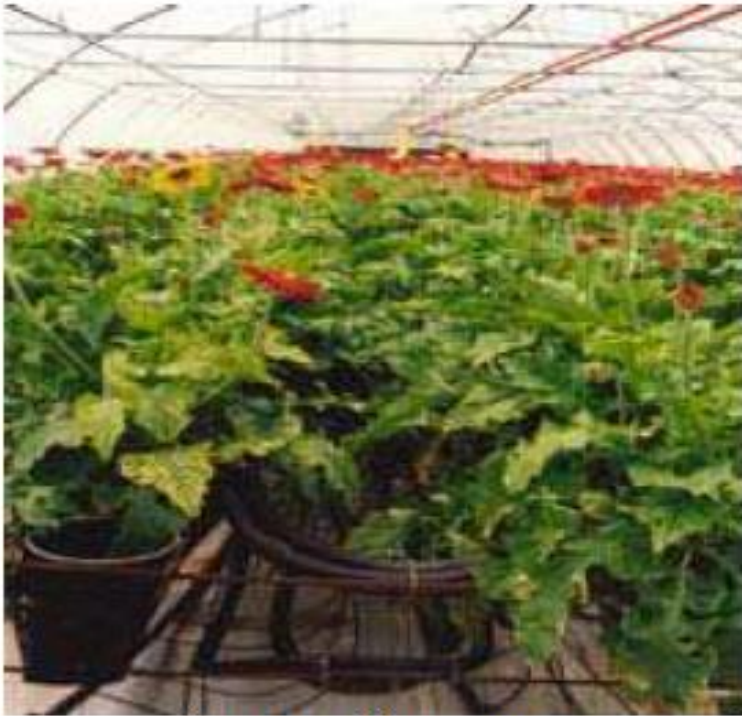
άμεση θέρμανση με σωλήνες PP Λέσβος
