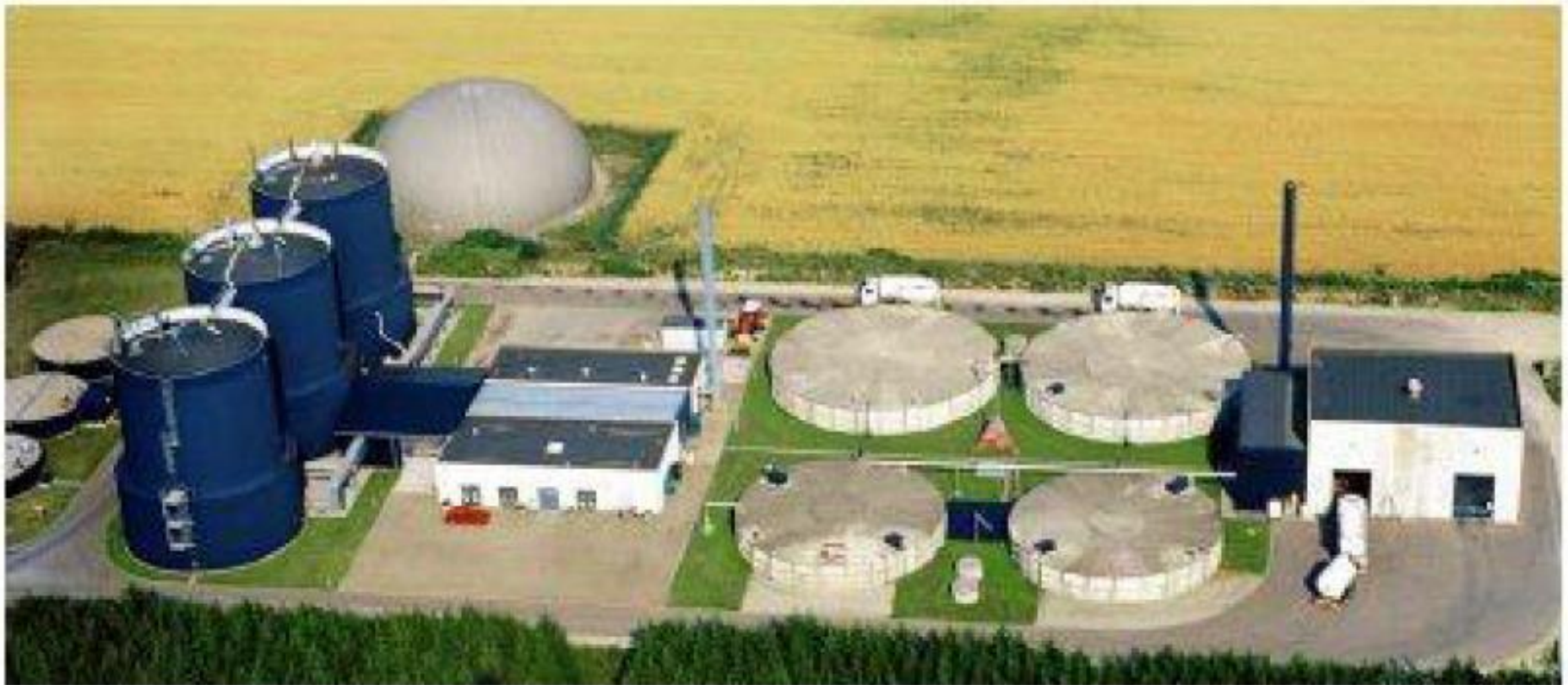
Σχήμα 4.8: Εικόνα μιας εγκατάστασης συγχώνευσης από τη Δανία (LEMVIG BIOGAS)
