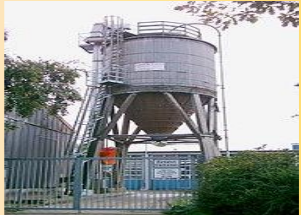
Μεταλλικό σιλό για αποθήκευση χαλκιού στην Γερμανία
