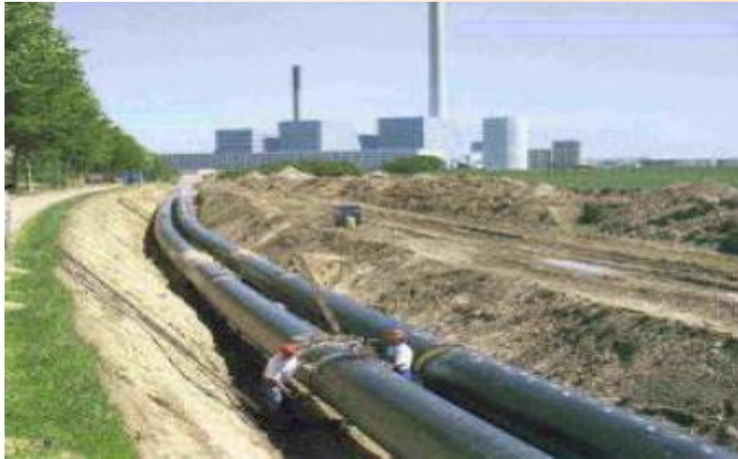
Κατασκευή δικτύου Τηλεθέρμανσης στην πόλη της Πτολεμαΐδας.
