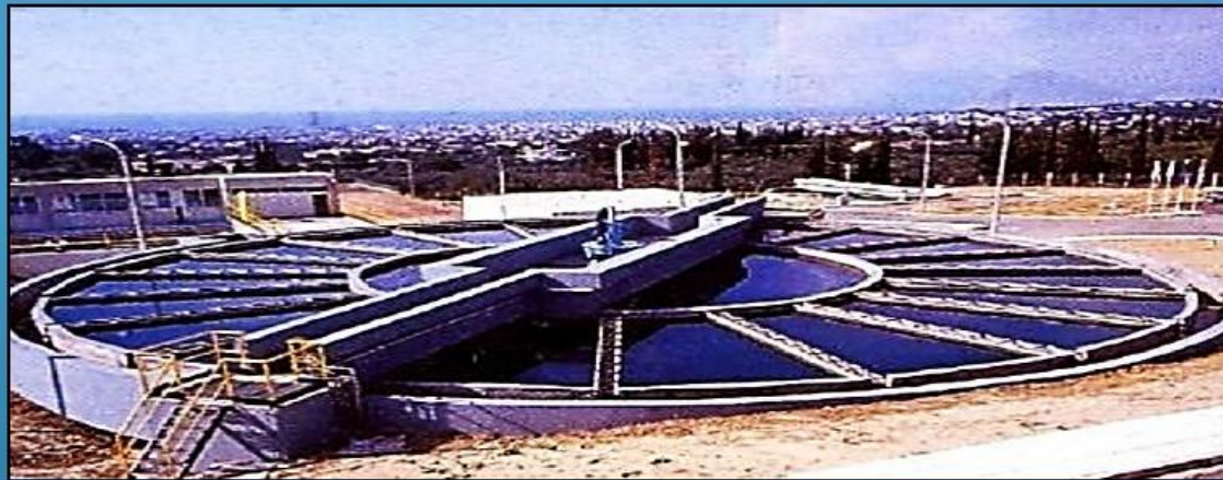
Δεξαμενή Κροκίδωσης – Καθίζησης
