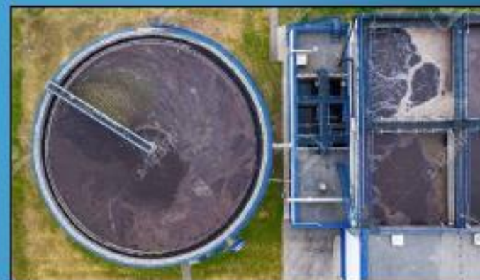
Μονάδα επεξεργασίας νερού: Ιζηματοποίηση, ( www.123rf.com )
