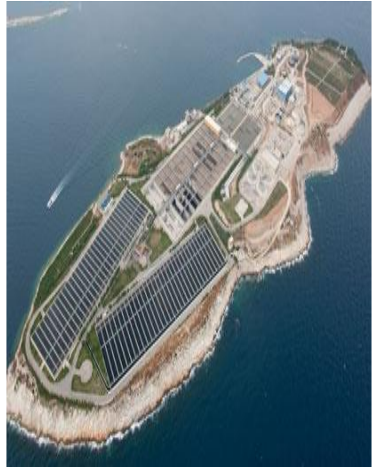
Εγκατάσταση Επεξεργασίας Λυμάτων στην Ψυττάλεια
