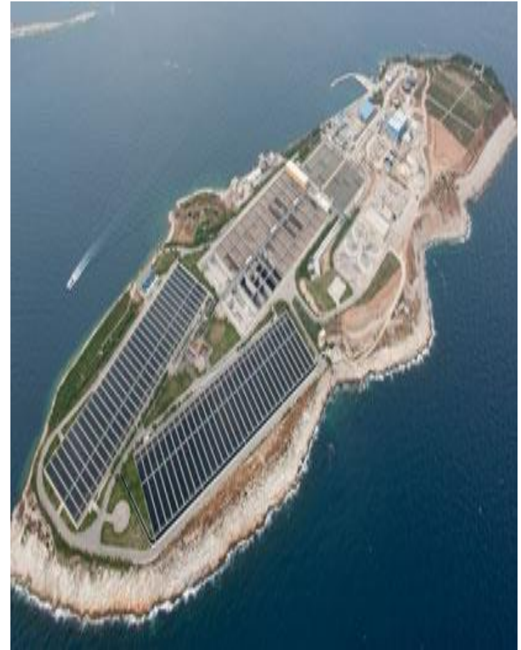
Εγκατάσταση Επεξεργασίας Λυμάτων στην Ψυττάλεια
