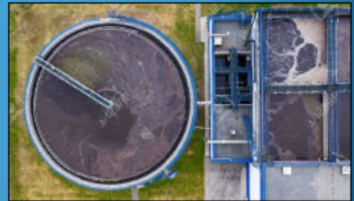
Μονάδα επεξεργασίας νερού: Ιζηματοποίηση, ( www.123rf.com )
