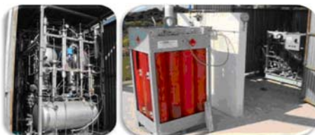
Διάταξη αποθήκευσης Υδρογόνου ΠΕΝΑ-ΚΑΠΕ_Πικέρμι
