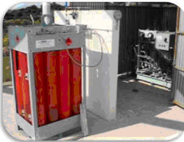
Διάταξη αποθήκευσης Υδρογόνου ΠΕΝΑ-ΚΑΠΕ_Πικέρμι
