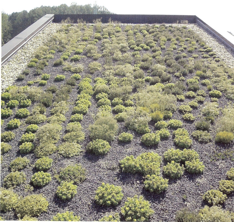
Τα φυτεμένα δώματα συμβάλλουν στη βελτίωση των θερμικών συνθηκών των κτιρίων.
