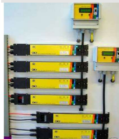
Αντιστροφέας με ενσωμάτωση στο φ/β πάνελ
