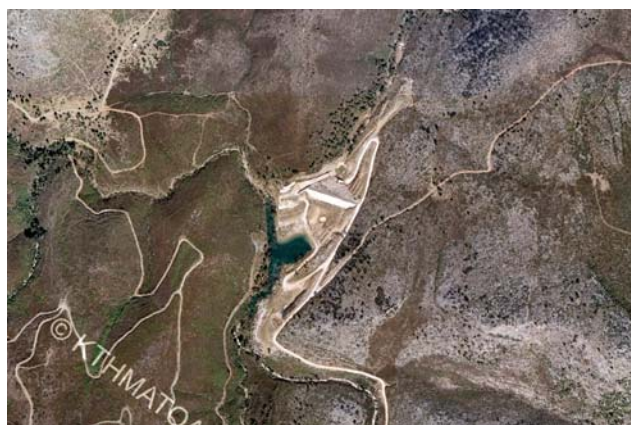
Σχήμα 7.72: Φράγμα Ραπεντώσας (υπόβαθρο ορθοφωτοχάρτη ΕΚΧΑ Α.Ε., περίοδος λήψης 2007-2009)
