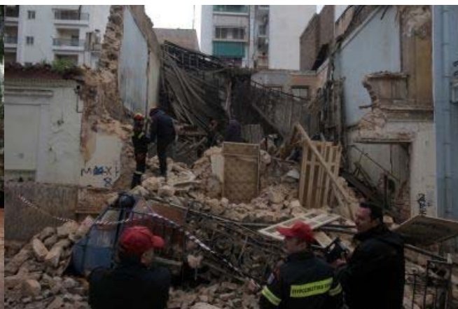
Κτήριο που κατέρρευσε στον Άγιο Παντελεήμονα – Οδός Μαγνησίας
