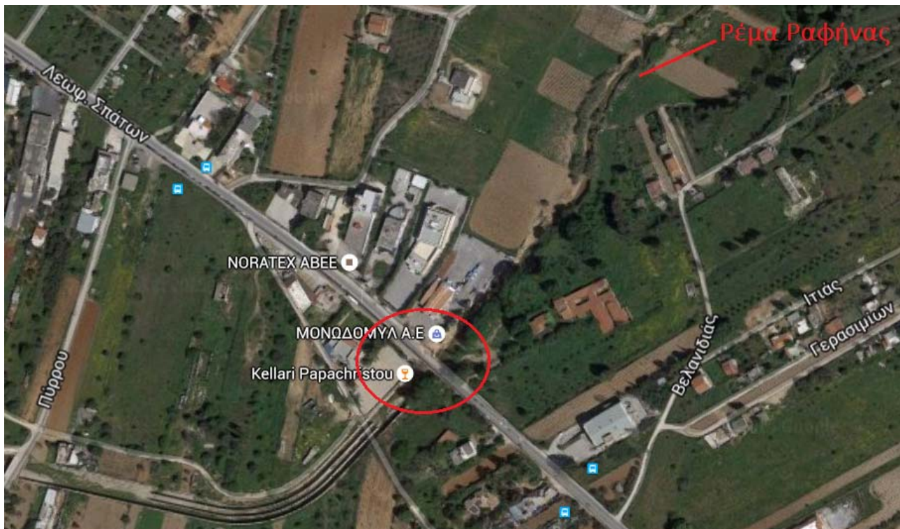
Σχήμα 7.19: Γέφυρα επί της Λεωφόρου Σπάτων που καταστράφηκε το οδόστρωμα στην πλημμύρα της 22/02/2013.
