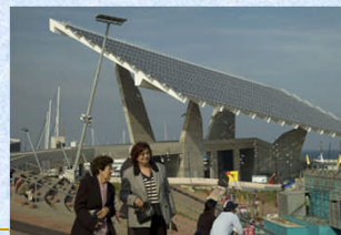
Solar Pergola, Ισπανία
