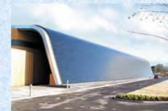
Ενσωμάτωση φωτοβολταϊκών σε δημόσιο κτίριο
