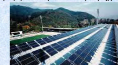
Ενσωμάτωση φωτοβολταϊκών σε γήπεδο ποδοσφαίρου
