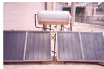
Αντιπροσωπευτική διάταξη ηλιακού συστήματος παραγωγής ζεστού νερού.
