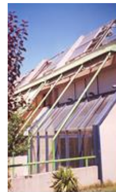
Προσαρτημένα ηλιακά θερμοκήπια που επικοινωνούν με τοίχους Trombe, και ηλιακοί συλλέκτες για τη παραγωγή ζεστού νερού. Για τα θερμοκήπια, έχει προβλεφθεί εξωτερική σκίαση.
