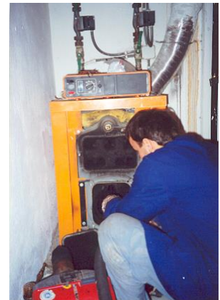
Μια εγκατάσταση που λειτουργεί με βαθμό απόδοσης 78% μπορεί μετά τη συντήρηση και την κατάλληλη ρύθμιση να φτάσει σε μια απόδοση 88,5% μειώνοντας την κατανάλωση καυσίμου κατά 12%.
