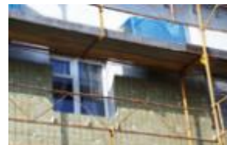
Μια καλά θερμομονωμένη κατοικία 100 π 2 εξοικονομεί περίπου 2 τόνους πετρέλαιο σε σχέση με ένα αμόνωτο κτίριο.
