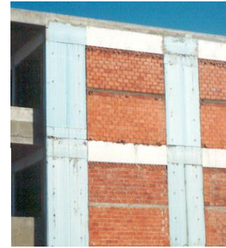
Εξωτερική θερμομόνωση σκελετού σε νέα κατασκευή.
