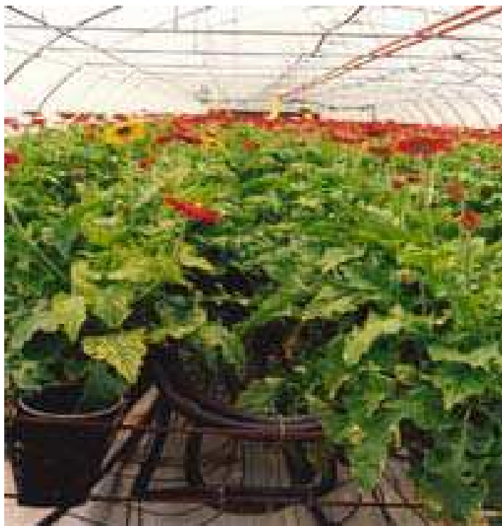
άμεση θέρμανση με σωλήνες PP Λέσβος
