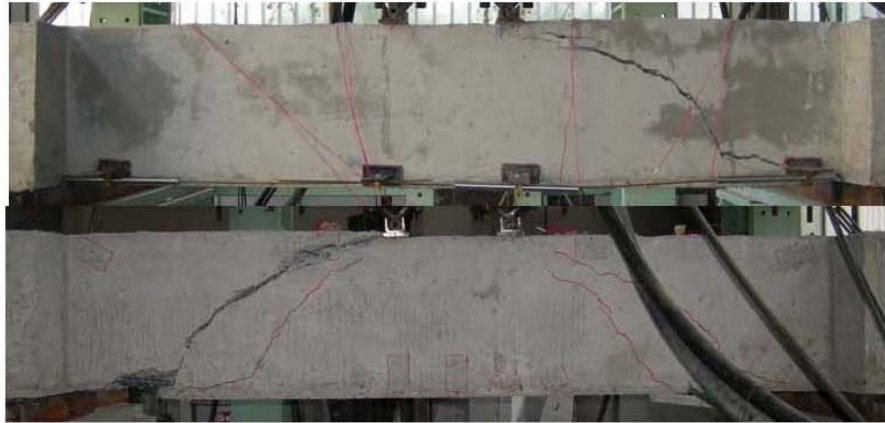
(β) Ρηγματώσεις του δοκμίου IVS μετά το πέρας της διαδικασίας φόρτισης
