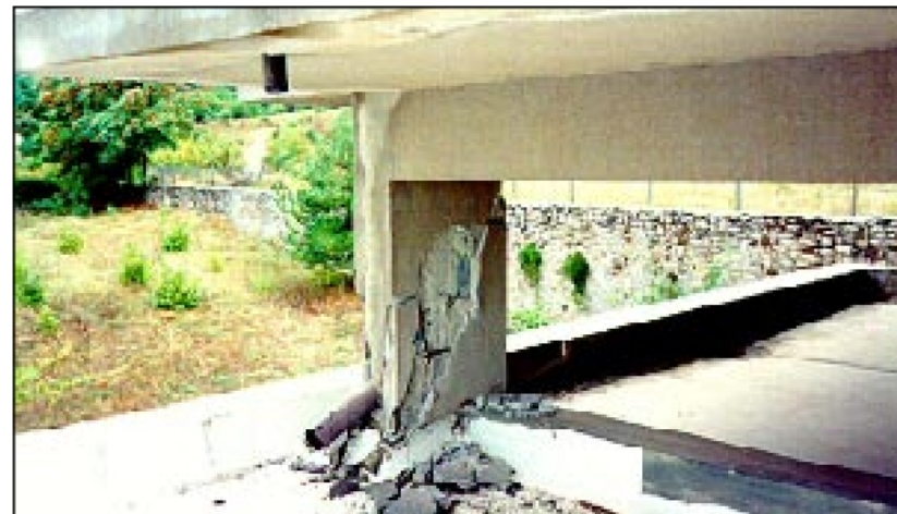
Συνέπειες κοντού υποστρώματος σε συνδυασμό με «κακή» όπλιση και κακοτεχνία (Κόνιτσα 1996). [Αρχείο Ι.Ε.Αβραμίδη]
