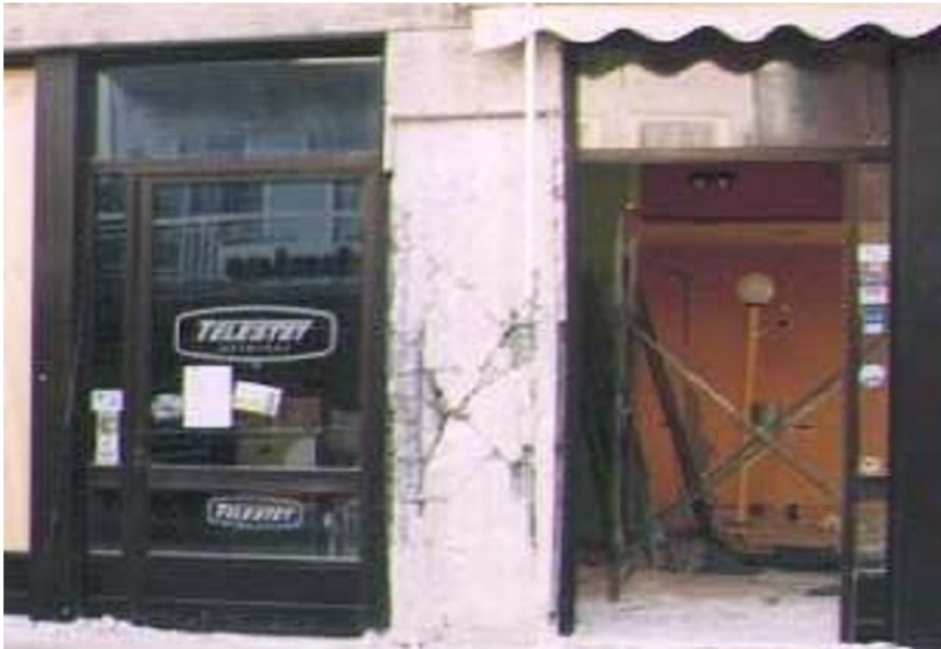
Φωτ. 7 Χαρακτηριστική βλάβη εκτός «κρίσιμου» μήκους
