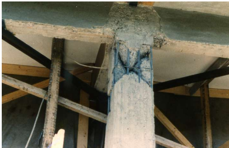
Συνέπειες κοντού υποστρώματος σε συνδυασμό με «κακή» όπλιση και κακοτεχνία (Κόνιτσα 1996). [Αρχείο Ι.Ε.Αβραμίδη]
