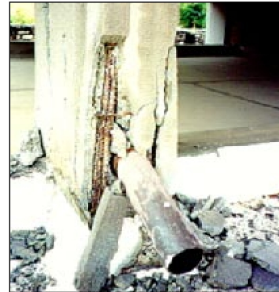
Συνέπειες κοντού υποστρώματος σε συνδυασμό με «κακή» όπλιση και κακοτεχνία (Κόνιτσα 1996). [Αρχείο Ι.Ε.Αβραμίδη]
