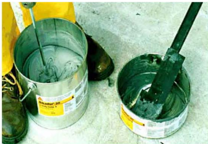
Εικόνα 5: Ανάμιξη εποξειδικής ρητίνης
