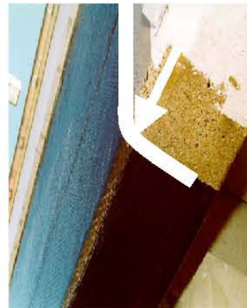
Εικόνα 4: Εξομάλυνση ακμών
