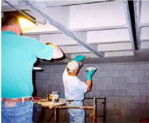
Εικόνα 9: Εφαρμογή ρητίνης στο υπόστρωμα
