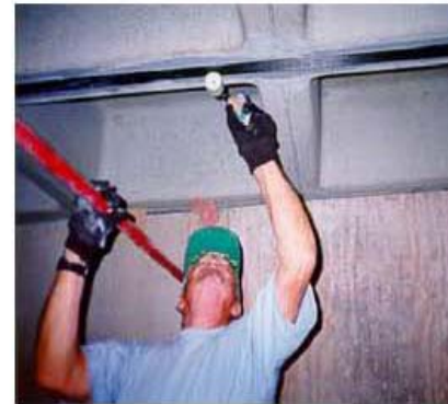
Εικόνα 12: “Ρολάρισμα” ελάσματος
