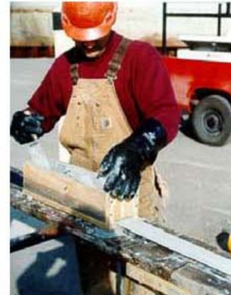
Εικόνα 10: Εφαρμογή ρητίνης στο έλασμα
