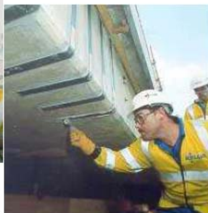
Εικόνα 16: “Ρολάρισμα” πλευρών γωνίας.
