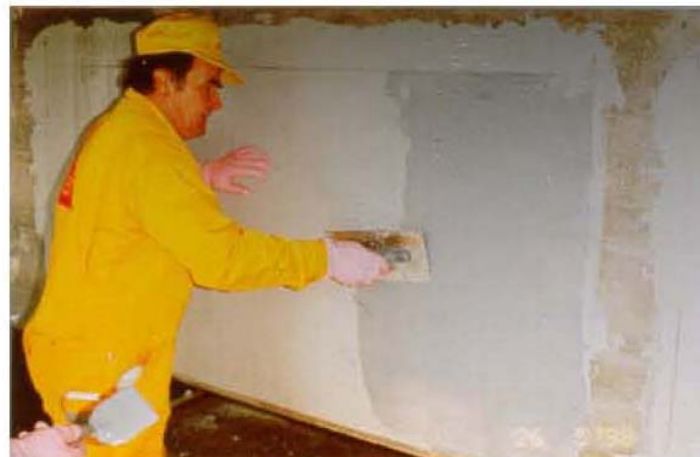
Εικόνα 6: Προεπάλειψη με Sikadur 330
