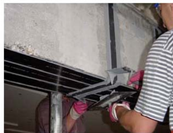
Εικόνα 16: Απομάκρυνση πλεονάζουσας ρητίνης.
