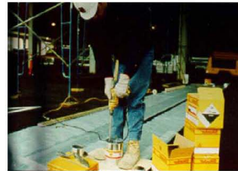
Εικόνα 11: Ανάμιξη εποξειδικής ρητίνης
