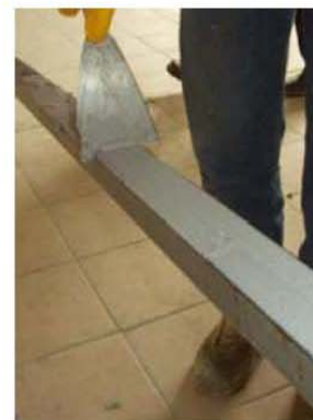
Εικόνα 13: Εφαρμογή ρητίνης στην γωνία.
