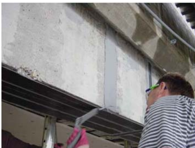
Εικόνα 14: Εφαρμογή ρητίνης στο υπόστρωμα.
