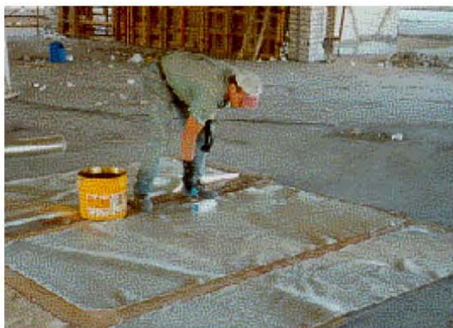
Εικόνα 7: Εμποτισμός με Sikadur 300
