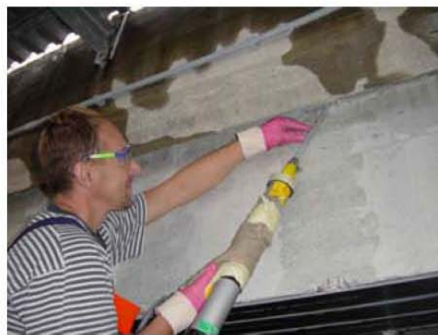
Εικόνα 12: Πλήρωση ζώνης αγκύρωσης με ρητίνη
