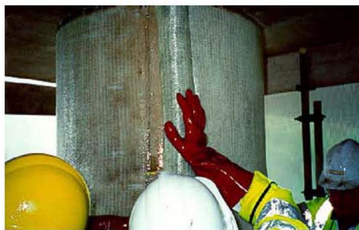
Εικόνα 8: Εμποτισμός με Sikadur 330
