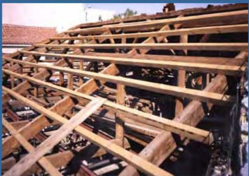
Αντικατάσταση των φθαρμένων ξύλινων δοκών της στέγης
