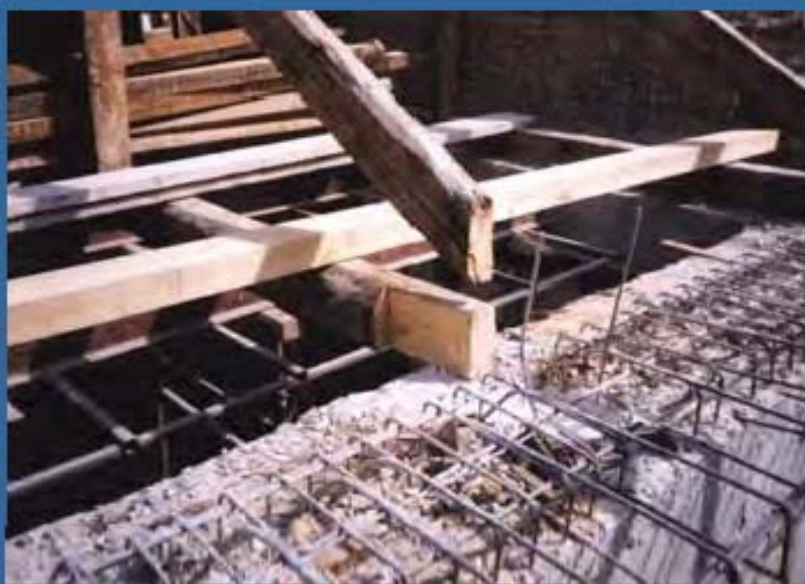
Αντικατάσταση των φθαρμένων ξύλινων δοκών της στέγης
