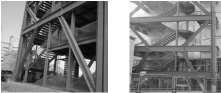
Σχήμα 4.30.: Εφαρμογή δικτυωτών συνδέσμων με εκκεντρότητα στο Κέντρο Τύπου των Ολυμπιακών Αγώνων του 2004.
