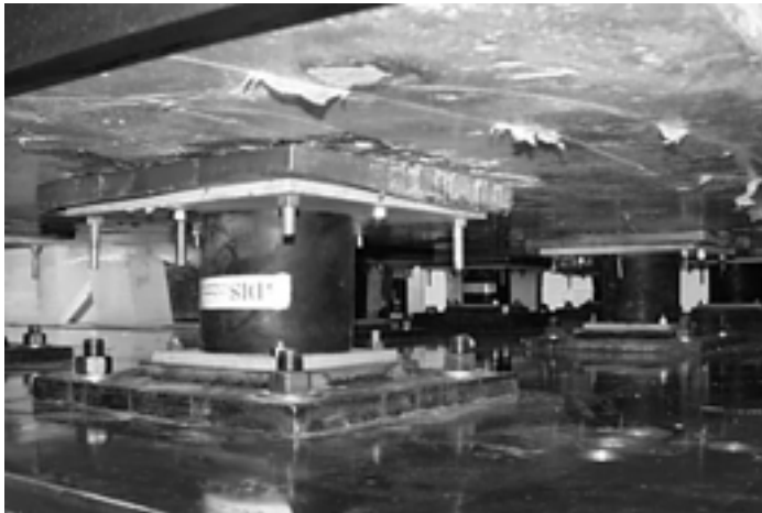
Σχήμα 7.4.: Ελαστομερές εφέδρανο χαμηλής απόσβεσης (κοινό ελαστομεταλλικό εφέδρανο – ELB).
