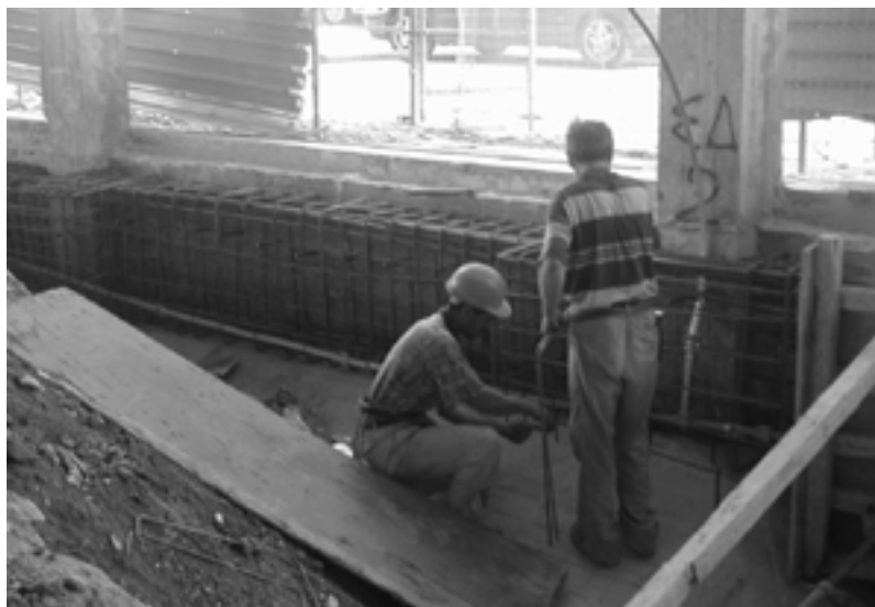
Σχήμα 9.5.: Κατασκευή περιμετρικής πεδילוδοκού.
