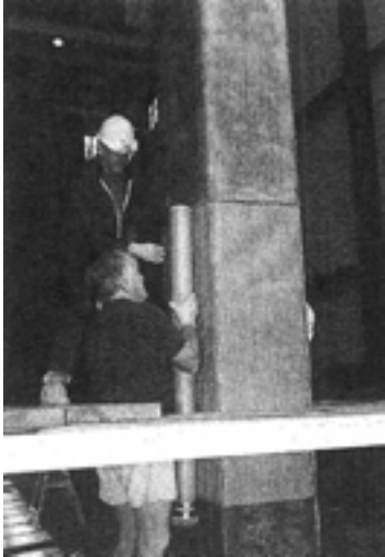
Σχήμα 8.7.: Ενίσχυση με μανδύες από σύνθετα υλικά. (α) Υαλονήματα υψηλής αντοχής: διάστρωση με το χέρι. (β) Ανθρακονήματα: μηχανική περιέλιξη.
