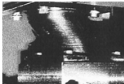
Σχήμα 7.9.: Ελαστομεταλλικό εφέδρανο υψηλής απόσβεσης (HDNR).
