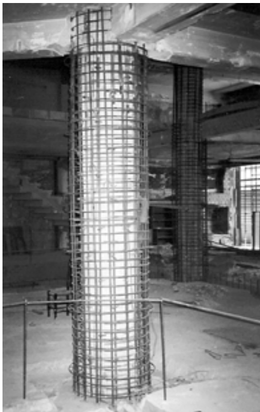
Σχήμα 1.3.: Ενίσχυση υποστυλώματος με μανδύα οπλισμένου σκυροδέματος.
