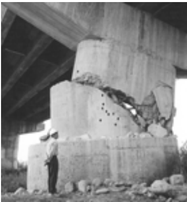
Σχήμα 8.3.: Αστοχία διατμητικού τύπου.
