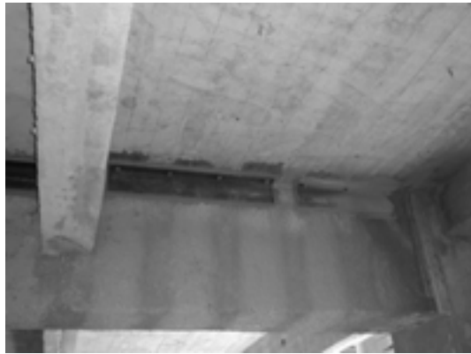
Σχήμα 6.10.: Αγκύρωση μανδύα σύνθετου υλικού για ενίσχυση πλακοδοκού.
