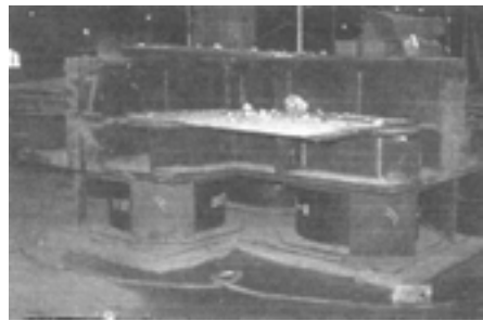
Σχήμα 7.12.: Μονωτήρες στο επίπεδο της θεμελίωσης του Δημαρχιακού Μεγάρου του San Francisco.
