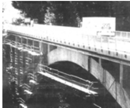
Σχήμα 6.2.: Ενίσχυση γέφυρας με σύνθετα υλικά στις Αυστριακές Άλπεις.
