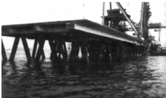
Σχήμα 6.6.: Ενίσχυση πασσάλων με σύνθετα υλικά ανθρακονημάτων στο Lamma Island Jetty του Χονγκ Κονγκ.
