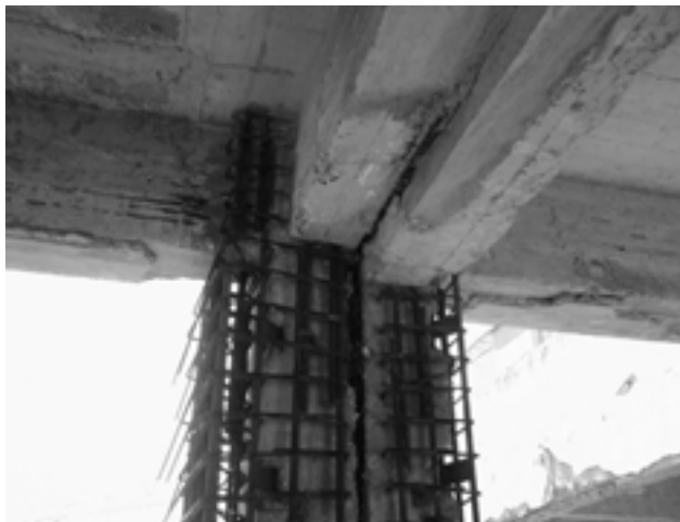
Σχήμα 4.21.: Κατασκευή ανοικτού μανδύα υποστυλώματος στην περιοχή αντισεισμικού αρμού.
