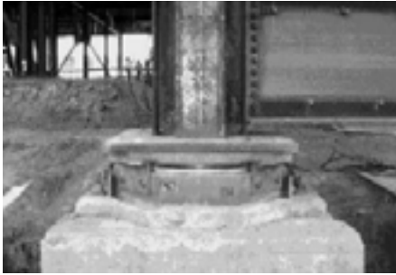
Σχήμα 7.5.: Εφέδρανο ολίσθησης που βασίζεται στην αρχή του εκκρεμούς (FPS).
