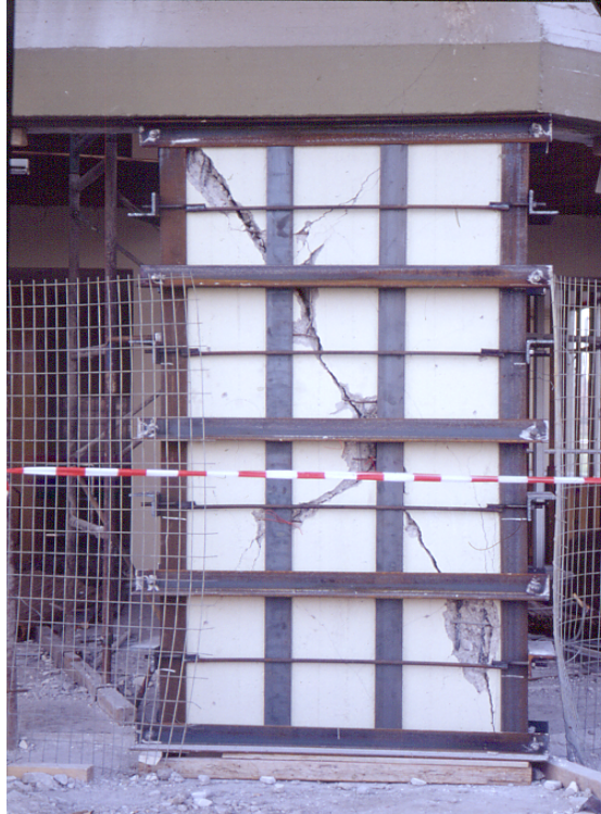
Σχήμα 1.10 Επέμβαση με μεταλλικό κλωβό για προσωρινή ανάληψη κατακόρυφων φορτίων
