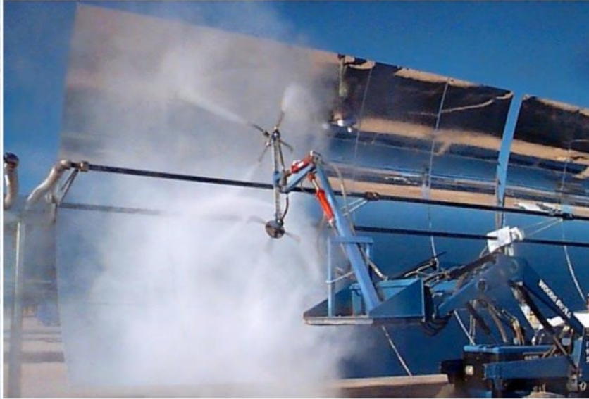
Καθαρισμός των κατόπτρων με νερό υψηλής πίεσης
