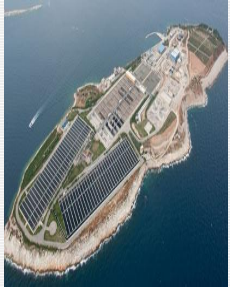
Εγκατάσταση Επεξεργασίας Λυμάτων στην Ψυττάλεια
